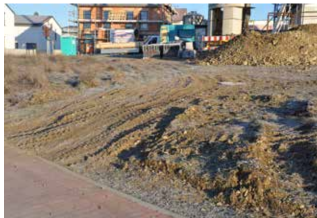
Baustelle im Hausgarten
